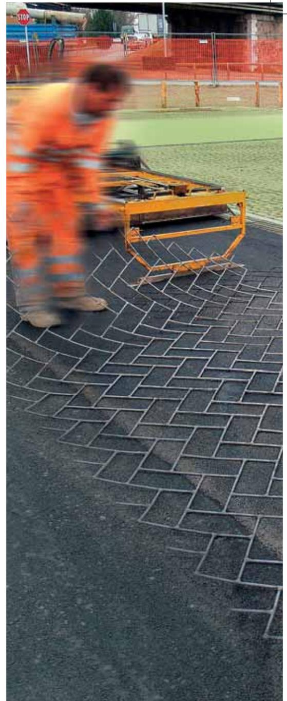
Fase di imprimitura con procedura di riscaldamento ad infrarossi dell'asfalto esistente
